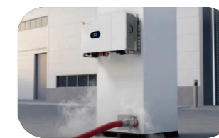
Zewnętrzny wlot wody gaśniczej
